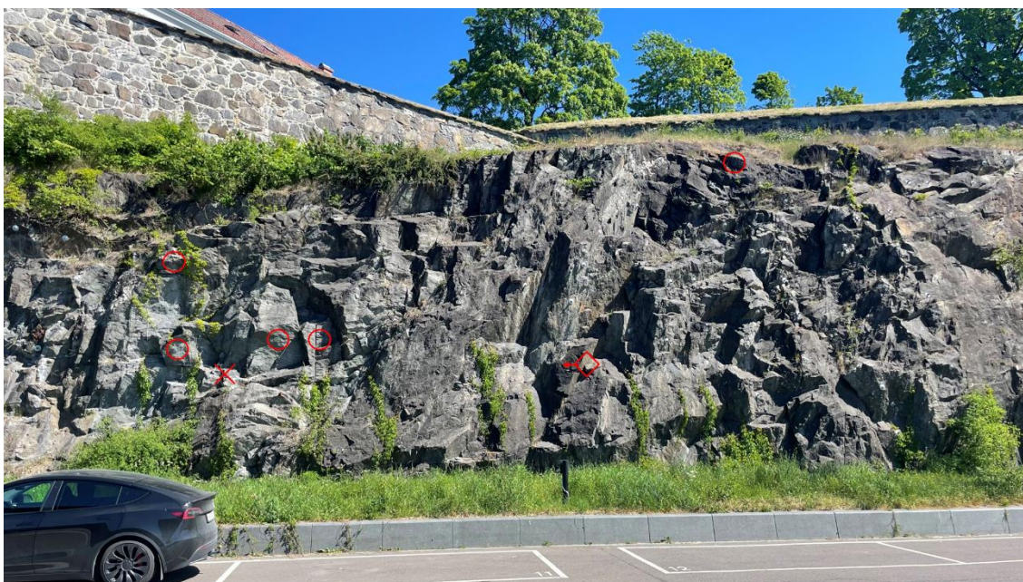
Figur 3-15 Det er anbefalt 5 stk. 2,4 m lange Ø20 mm bolter og 1 stk. 4 m lang bolt som skal boltes inn på tvers av bergsprekkene med retning som anvist på bildet. Det skal også renskes en løs blokk. Bilde tatt mot øst.
