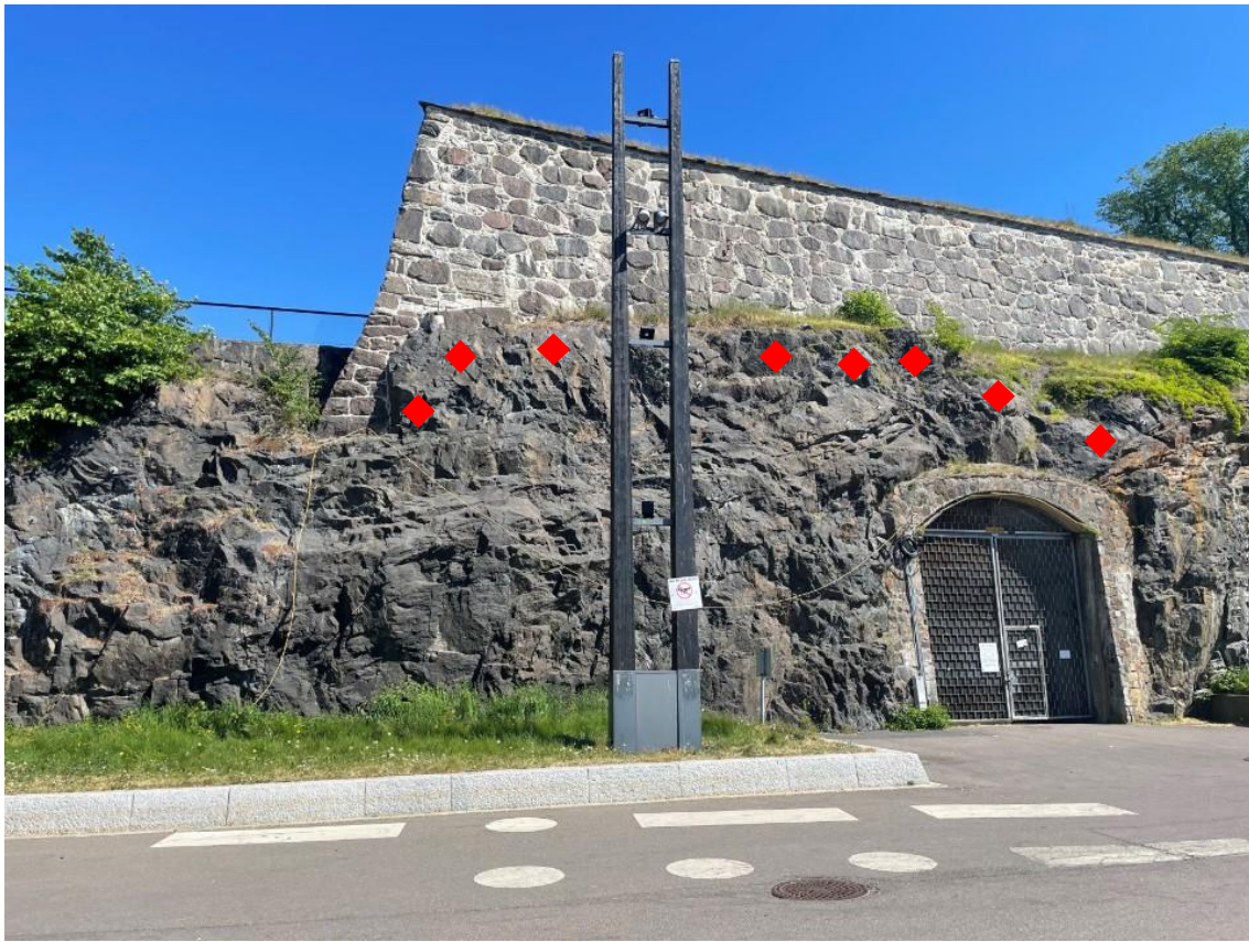
Figur 3-4 Festningsmuren er anlagt på toppen av bergskjæringen, nær skjæringskanten. Det er anbefalt 8 stk. 4 m lange Ø32 mm bolter. Bilde tatt mot øst.
