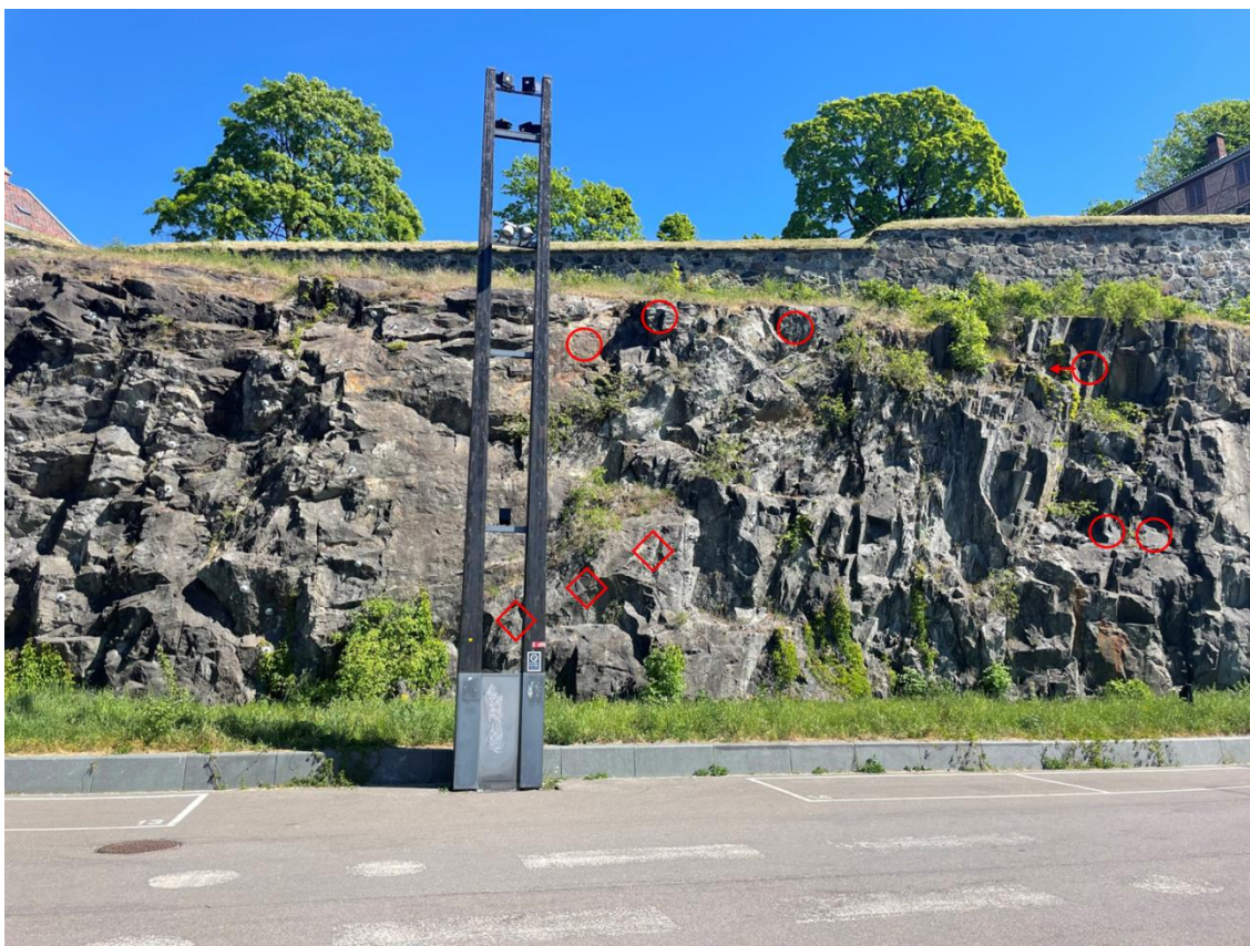
Figur 3-16 Det er anbefalt 6 stk. 2,4 m lange Ø20 mm bolter og 3 stk. 4 m lange Ø20mm bolter. Boltene øverst til høyre skal settes på tvers av bergsprekkene som angitt på bildet. Bilde tatt mot øst.
