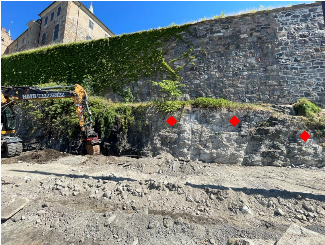
Figur 3-33 Det er anbefalt 3 stk. 4 m lange Ø32 mm bolter under muren. Bilde tatt mot øst.
