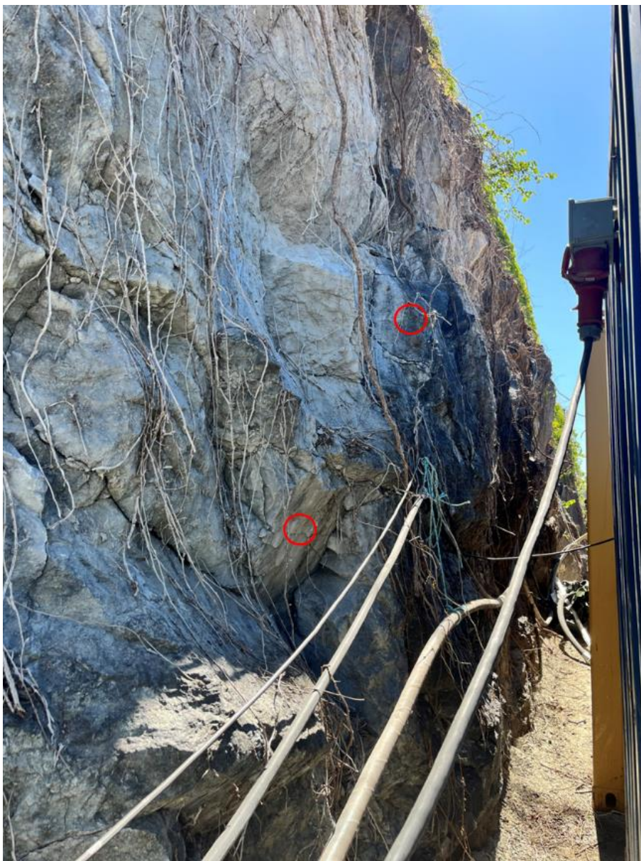
Figur 3-30 Det er anbefalt 2 stk. 2,4 m lange Ø20 mm bolter for blokksikring. Bildet tatt bak den blå containeren (se Figur 3-29) mot sør.
