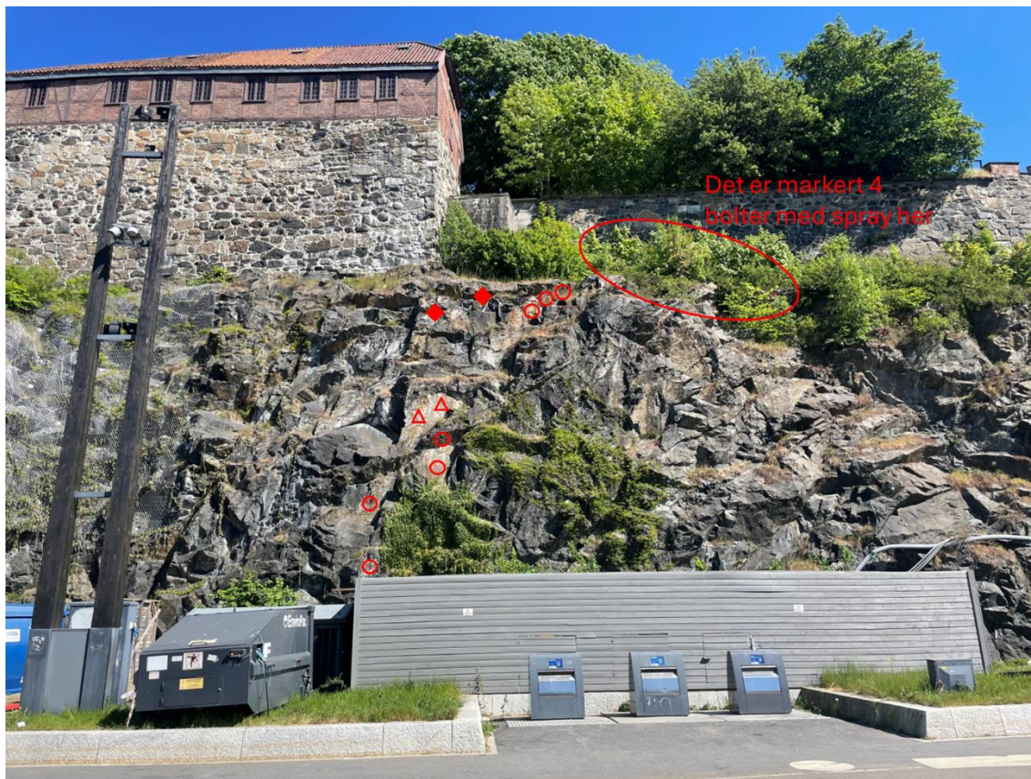
Figur 3-22 Det anbefales 4 stk. 2,4 m lange Ø20 mm bolter øverst i skjæringen i buskene. Disse er merket med spray på berget. I tillegg er det anbefalt 7 stk. 2,4 m lange Ø20 mm bolter, 2 stk. 3 m lange Ø20 mm bolter og 2 stk. 4 m lange Ø32 mm bolter. Bildet er tatt mot øst.
