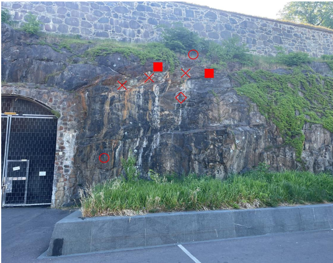
Figur 3-5 Det er anbefalt rensk av løse blokker i et parti med dårlig berg. Dersom blokken øverst i bildet ikke kan renskes skal den sikres med 1 stk. 2,4 m lang Ø20 bolt. Det er ellers anbefalt 2 stk. 6 m lange Ø32 mm bolter, 1 stk. 4 m lang Ø20 mm bolt og 1 stk. 2,4 m lang Ø20 mm bolt nederste i bildet. Bilde tatt mot øst.
