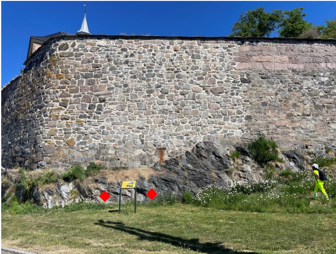
Figur 3-34 Det er anbefalt 2 stk. 4 m lange Ø32 mm bolter under muren. Bildet tatt mot nordøst.
