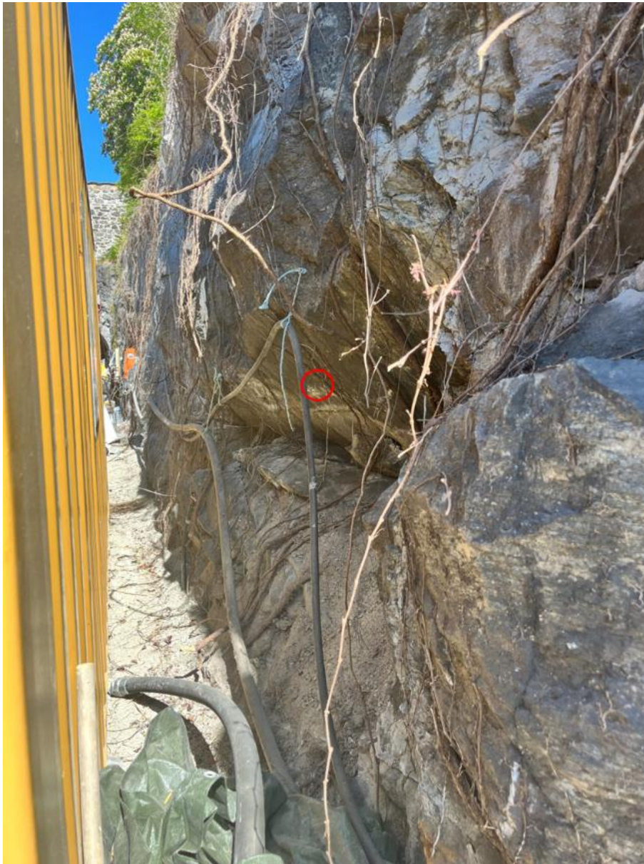
Figur 3-31 Det er anbefalt 1 stk. 2,4 lange bolt for blokksikring. Bildet bak den gule containeren mot nord (se Figur 3-29).
