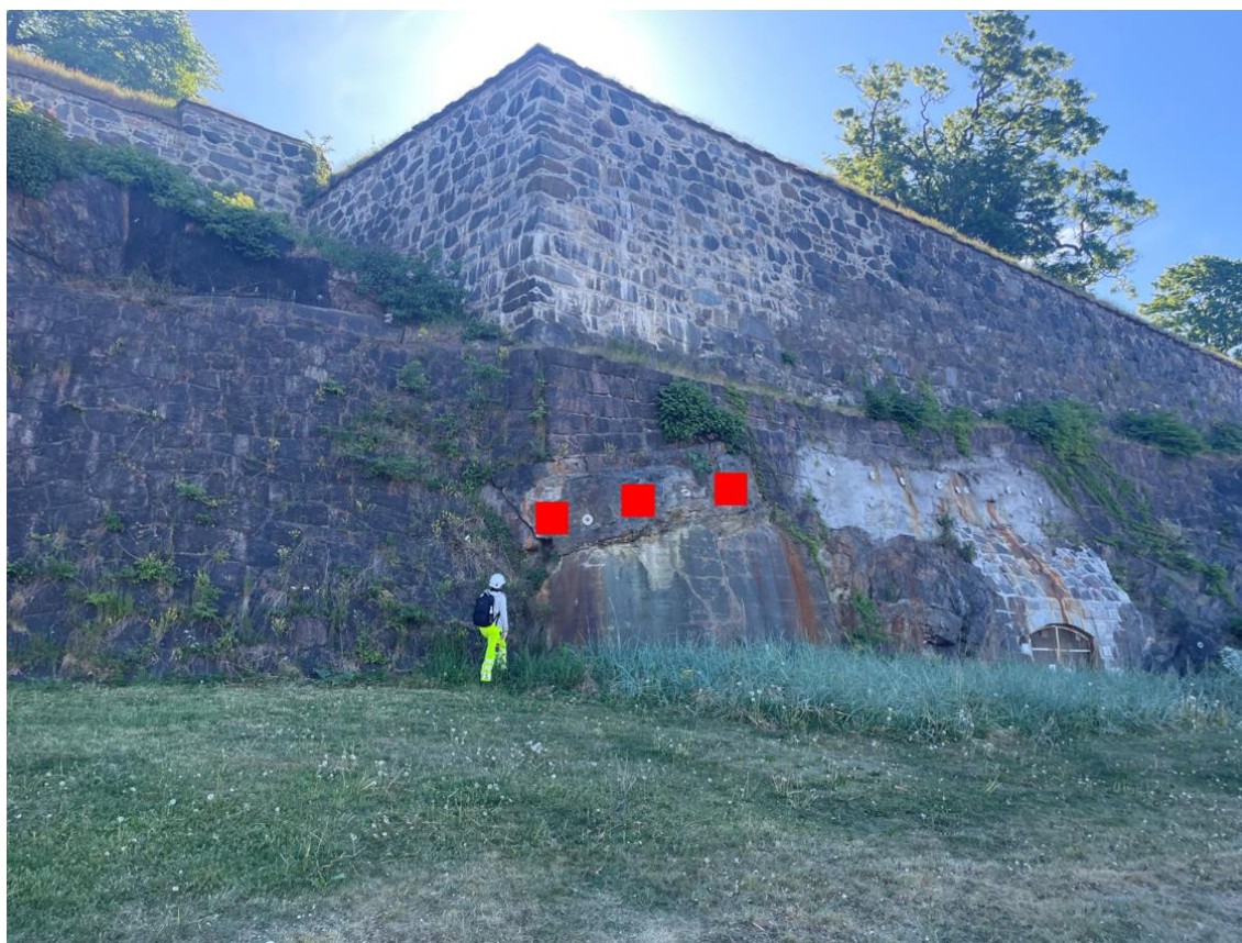
Figur 3-8. Det er en blokk med åpen sprekk bak som er sikret med 2 stk. 3 m lange bolter [4]. Det er usikkert når sprekken åpnet (se neste figur). Det anbefales å utføre ekstra sikring av blokken med 3 stk. 6 m lange Ø32 mm bolter. Dette er et kritisk område hvor skjæringen er bygget inn med en blokk- og betongmur. Grensen mellom berget og konstruksjonene er en slags svakhetszone. Festningsmuren sitter i tillegg tett på toppen av konstruksjonen. Bilde tatt mot sørøst.
