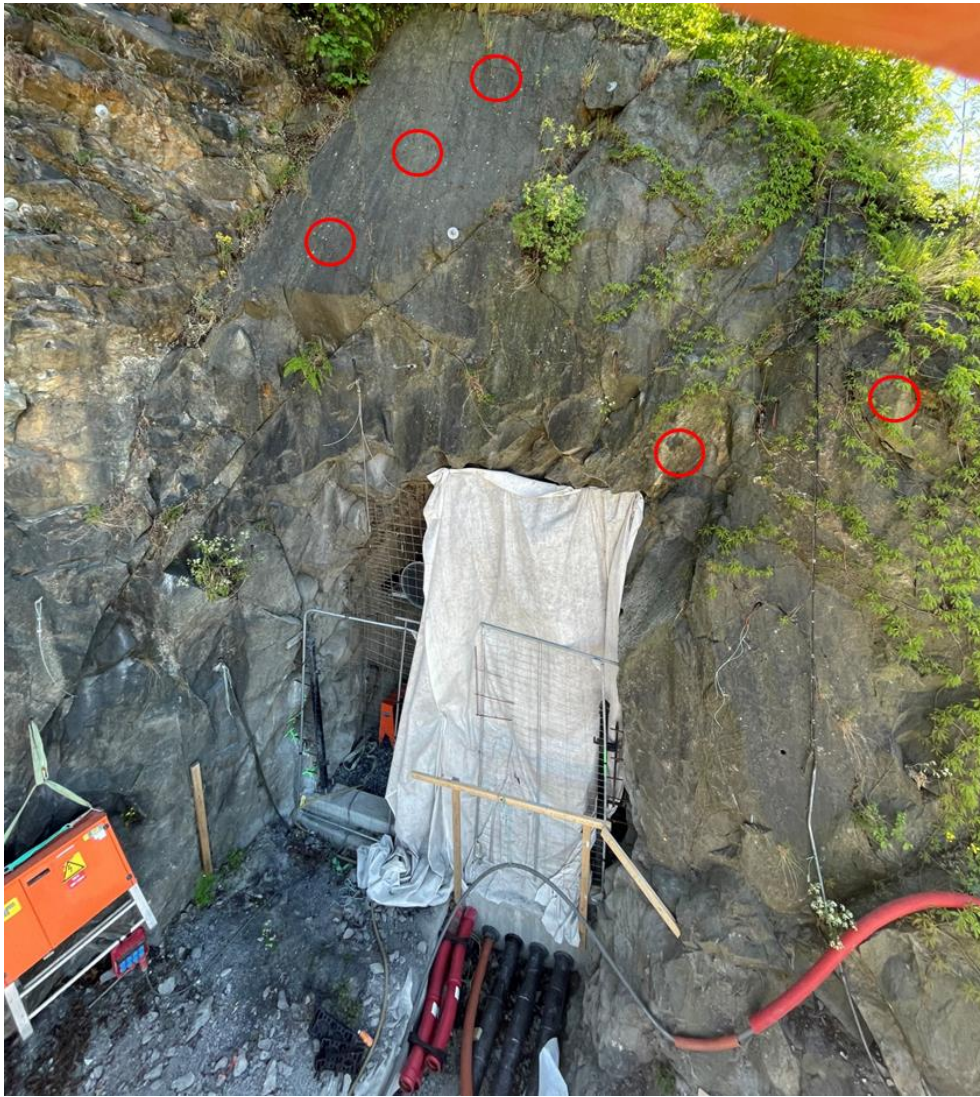
Figur 3-24 Det er anbefalte 5 stk. 2,4 m lange Ø20 mm bolter ved påhugget. Bildet er tatt mot sør.
