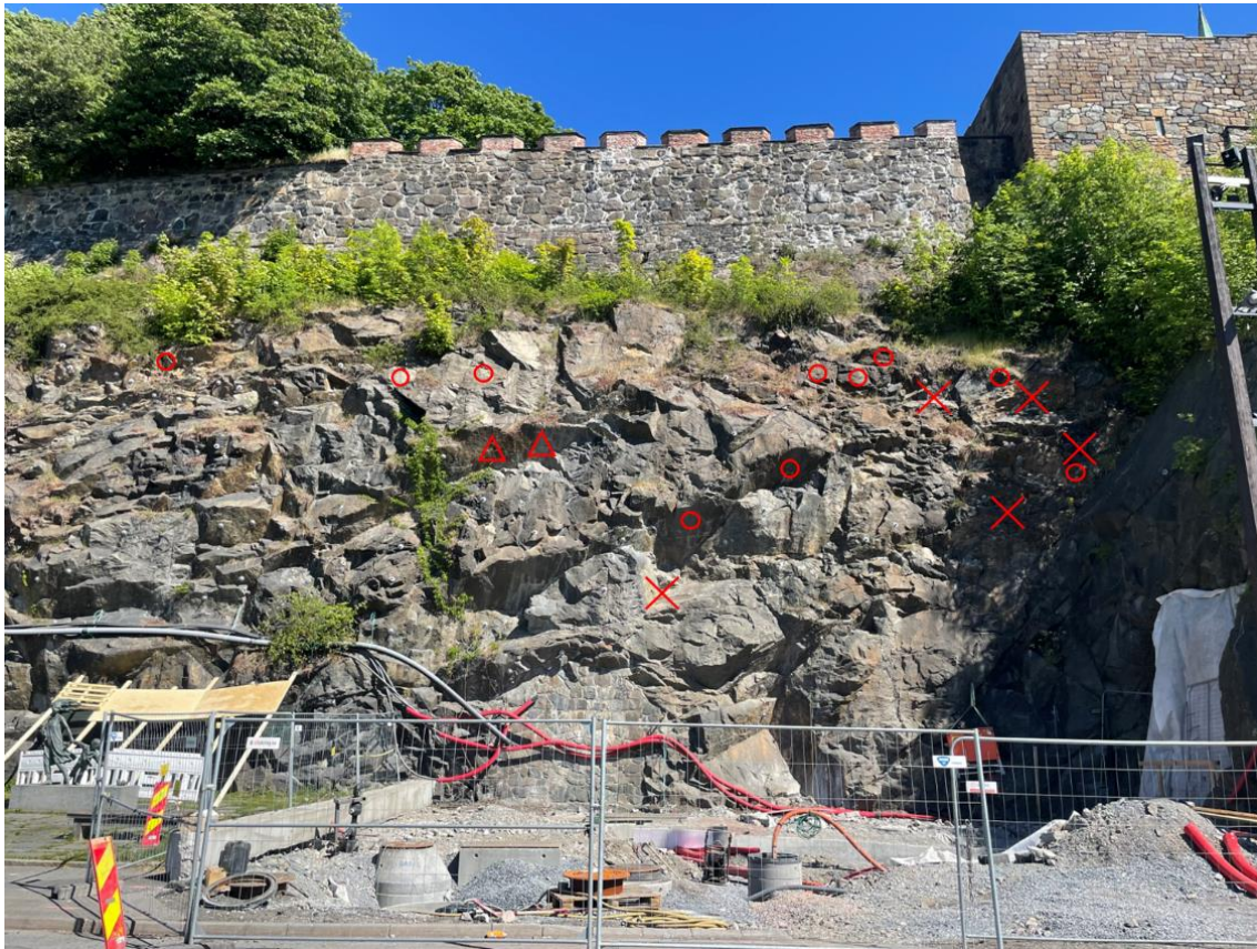
Figur 3-23 Det er anbefalt rensk av løse blokker og partier med dårlig berg i den sørlige enden av delområde 3. Det er anbefalt 10 stk. 2,4 m lange og 2 stk. 3 m lange Ø20 mm bolter. Bildet er tatt mot øst, med Scandinavian Star-minnesmerket nede til venstre i bildet.
