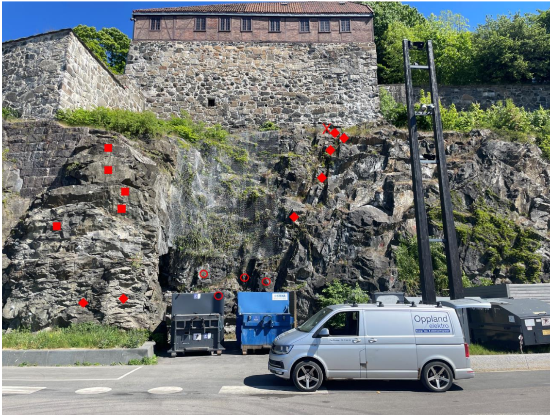
Figur 3-20 Eksisterende steinsprangsnett skal tømmes og feste med bergbånd på bunnen. Det er anbefalt rensk av løse blokker øverst i skjæringen rett under festningsmuren. Om blokkene ikke kan renskes skal de boltes med 2,4 m lange Ø20 mm bolter. Videre er det anbefalt 4 stk. 2,4 m lange, 7 stk. 4 m lange og 5 stk. 6 m lange Ø32 mm bolter. Nær bildet bak søppel containere er vist i Figur 3-21. Bildet er tatt mot øst.
