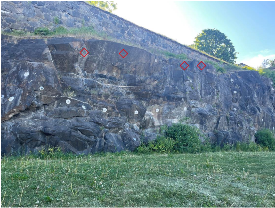
Figur 3-12 Det anbefales 4 stk. 4 m lange Ø20 mm bolter øverst i skjæringen. Bilde tatt mot øst.
