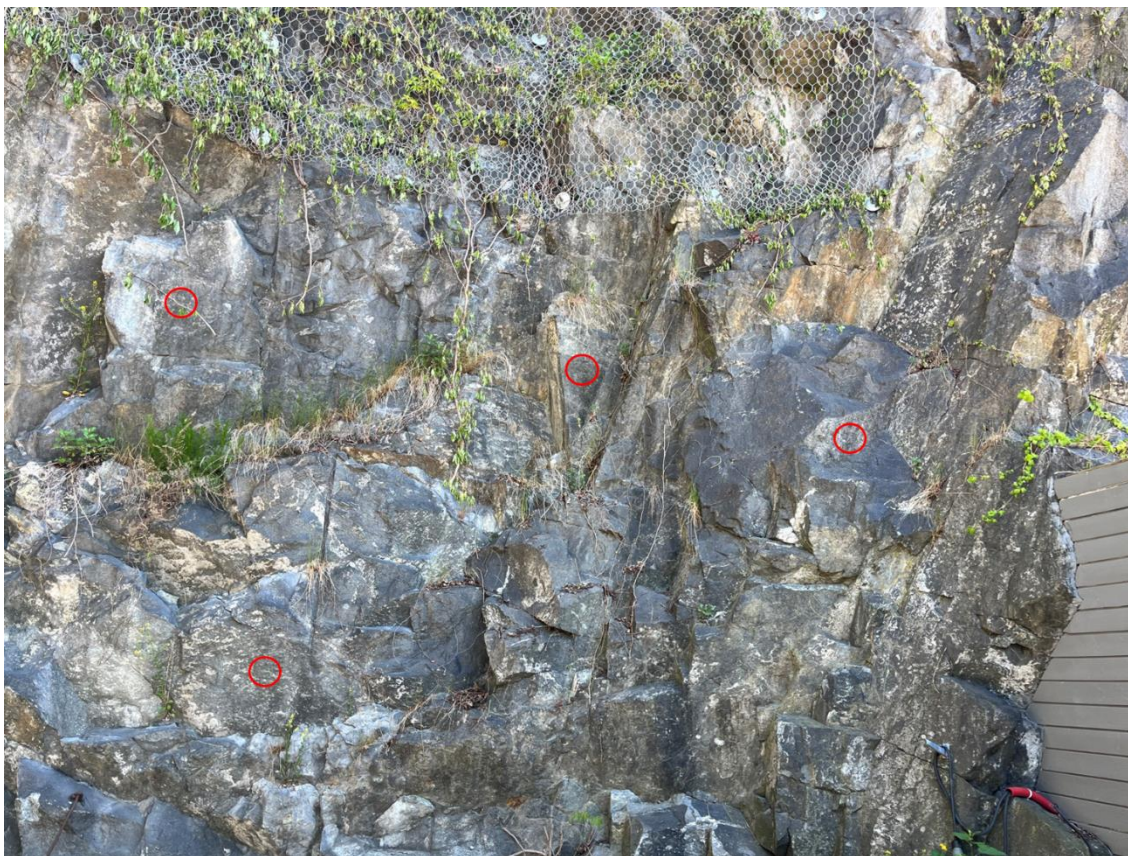
Figur 3-21 Bildet tatt bak søppel containere hvor det er anbefalt 4 stk. 2,4 m lange Ø20 mm bolter. Eksisterende steinsprangsnett skal festes med ca. 6 m bergbånd på bunnen. Bildet er tatt mot øst.
