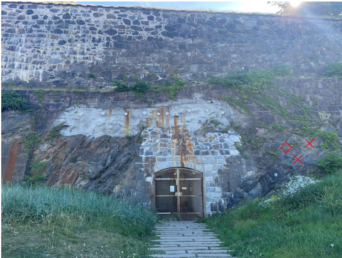
Figur 3-10 Det er noen eksisterende bolter over påhugg [4]. Bolteplatene henger i løse luften og skal strammes. Det er anbefalte 1 stk. 4 m lange Ø20 mm bolt og noe rensk til høyre for porten. Bilde tatt mot øst.
