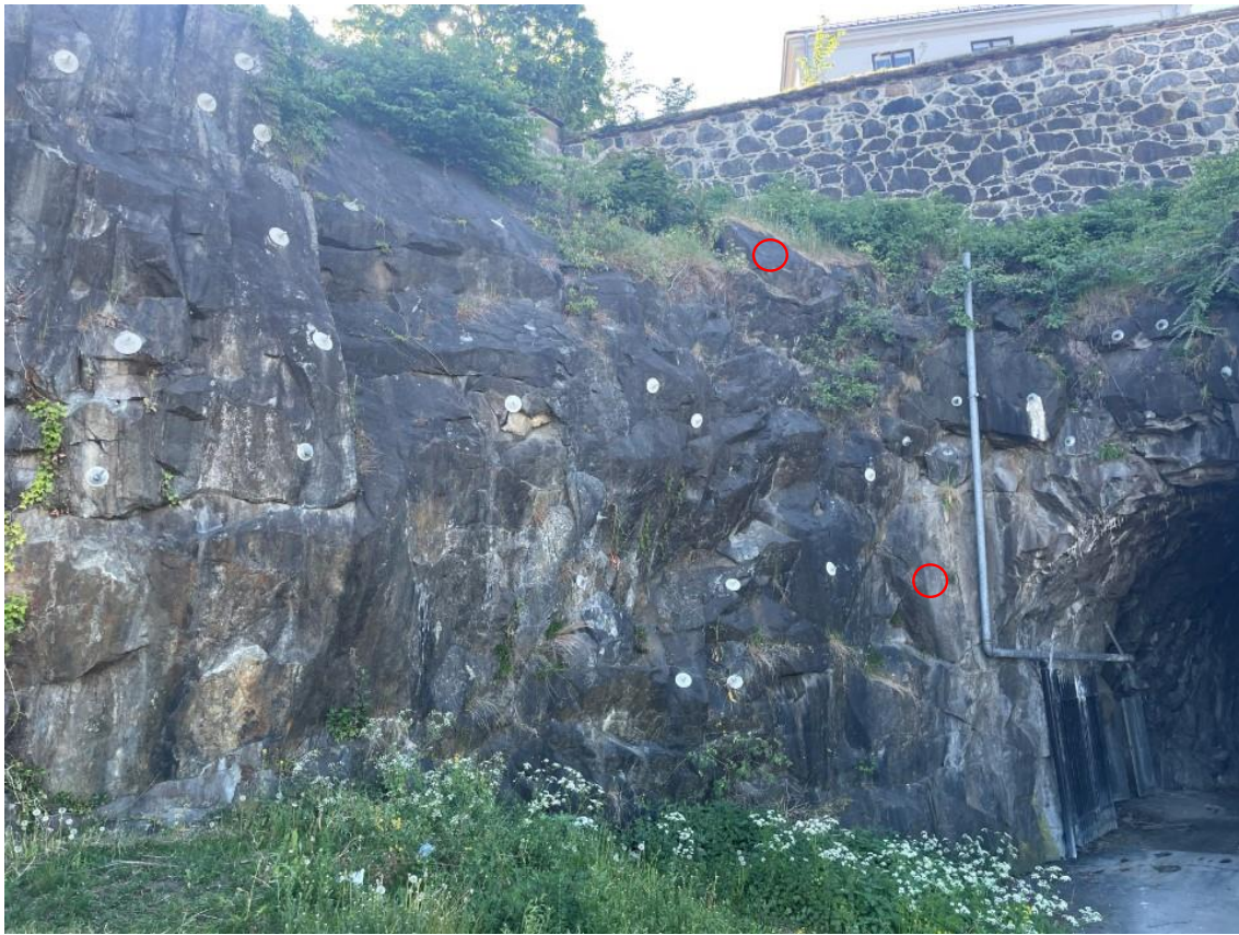
Figur 3-13 Det anbefales 2 stk. 2,4 m lange Ø20 mm bolter. Bildet tatt mot sør øst ved tunnelpåhugget.
