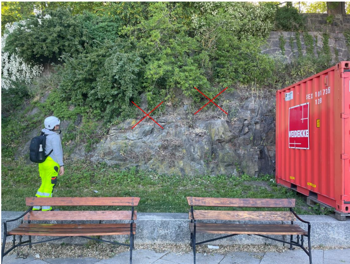
Figur 3-1 Det er behov for rensk av løse blokker og vegetasjon i skjæringen. Bildet er tatt mot øst.
