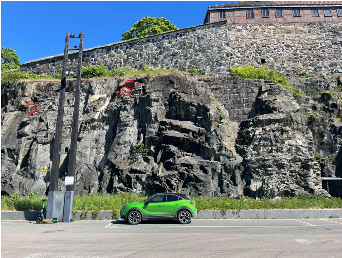
Figur 3-17 Det er anbefalt 3 stk. 2,4 m lange Ø20 mm bolter øverst i skjæringen. Bilde tatt mot øst.
