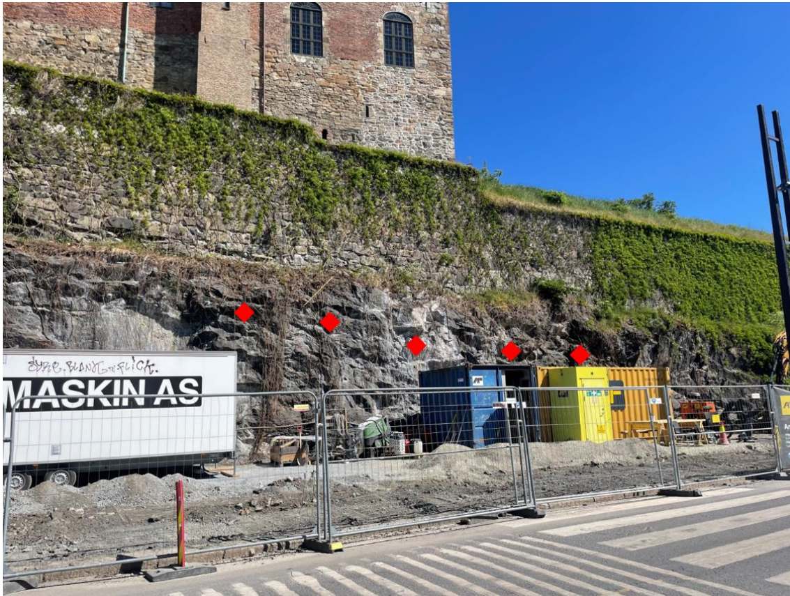
Figur 3-29 Det er anbefalt 5 stk. 4 m lange Ø32 mm bolter øverst i skjæringen under festningsmuren. Skjæringen bak den blå og gule containeren er vist i de neste figurene. Bilde tatt mot øst.
