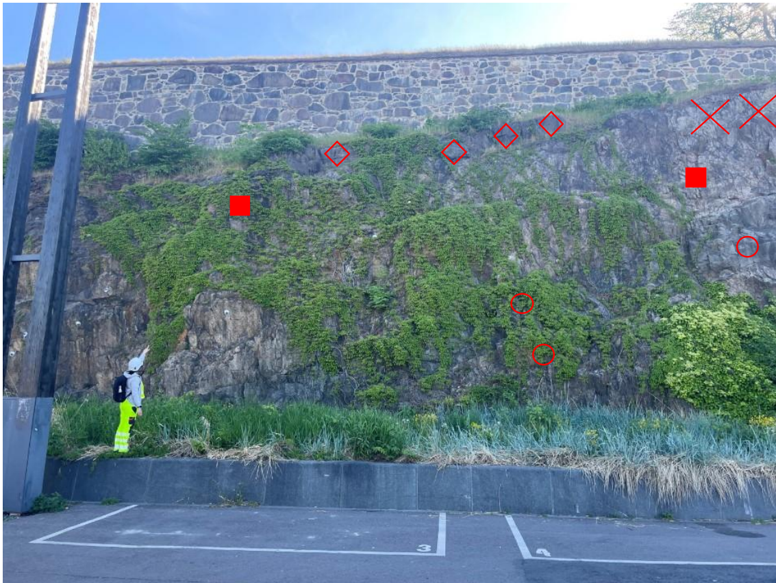
Figur 3-6 Det er anbefalt 4 stk. 4 m lange bolter øverst i skjæringen. Videre er det anbefalt 2 stk. 6 m lange Ø32 mm bolter, og 3 stk. 2,4 m lange bolter lavere i skjæringen. Det skal renskes noen løse blokker i øverste delen. Bilde tatt mot øst.
