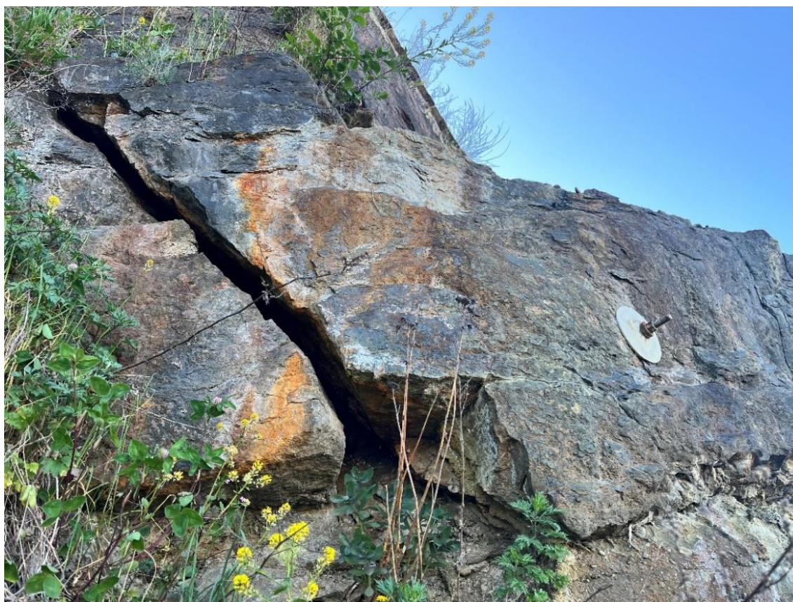
Figur 3-9 Sprekken bak blokk i skjæringen er åpen. Bilde tatt mot sør.
