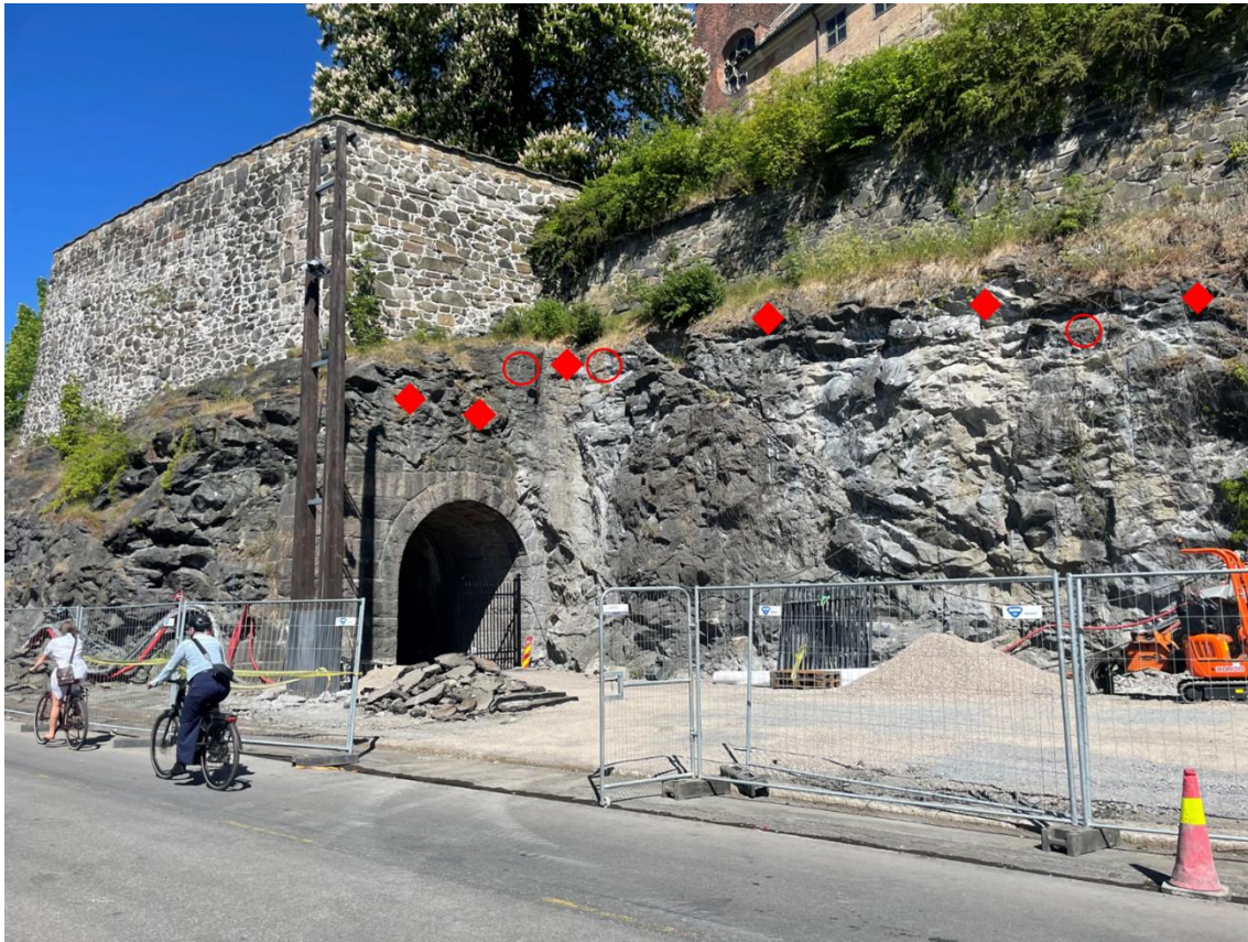
Figur 3-26 Ved tunnelpåhugget anbefales det at skjæringen sikres med bolter. Det er videre anbefalt 6 stk. 4 m lange Ø32 mm bolter øverst i skjæringen. I tillegg er det anvist 3 stk. 2,4 m lange Ø20 mm bolter. Bildet er tatt mot nordøst.
