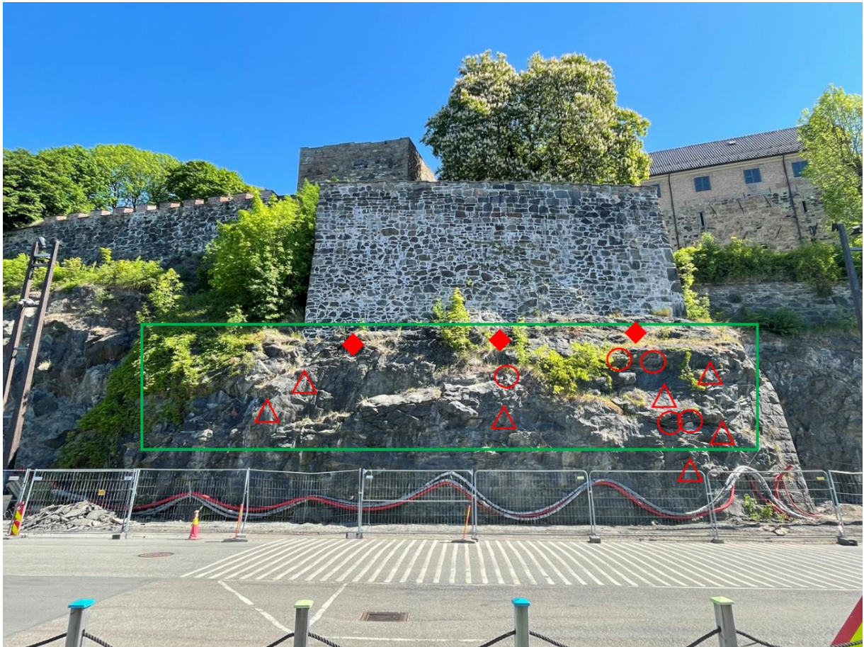
Figur 3-25 Det anbefales at det monteres steinsprangnett på skjæringen over fortauet. Nettet skal slutte 3 m over bakken og festes med ca. 12 m bergbånd på bunnen. Festeboltene skal være 0,8-1,5 m lange Ø20 mm. Boltemønster til festebolter skal være 1 bolt pr. 2,5 x 2,5 kv.meter uten midtbolt. På grunn av ujevn skjæringsflate kan det være behov for flere festebolter. Nett, skiver til festeboltene og bånd skal være i svart farge. Det anbefales 3 stk. 4 m lange Ø32 mm bolter øverst i skjæringen under festningsmuren. Det skal også sikres med 7 stk. 3 m lange og 5 stk. 2,4 m lange Ø20 mm bolter for lokal blokksikring. Bildet er tatt mot øst.
