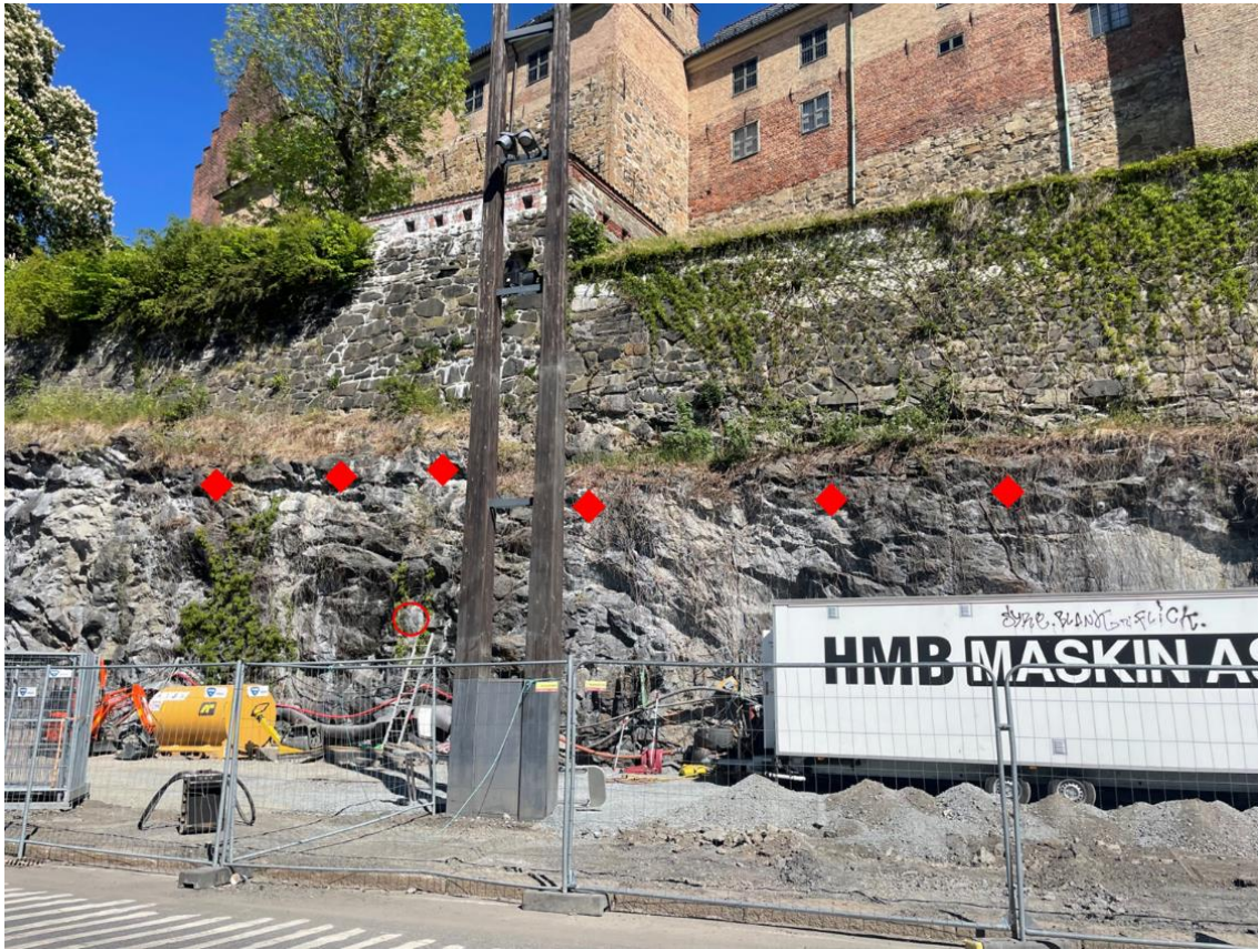
Figur 3-27 Det anbefales 6 stk. 4 m lange Ø32 mm bolter øverst i skjæringen under festningsmuren, samt 1 stk. 2,4 m lang Ø20 mm bolt for lokal blokksikring. Skjæringen bak den hvite containeren er vist i neste figur. Bildet er tatt mot øst.
