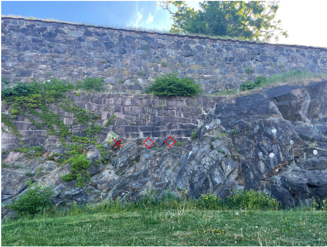
Figur 3-11 Det er anbefalt rensk og 2 stk. 4 m lange Ø20 mm bolter. Bilde tatt mot øst.
