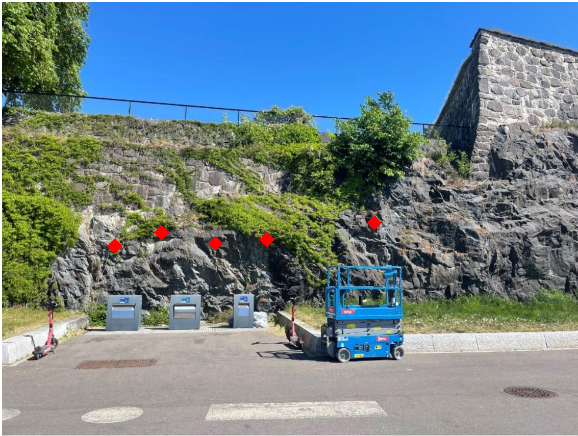
Figur 3-3 Det er anbefalt 5 stk. 4 m lange Ø32 mm bolter. Bildet er tatt mot øst.
